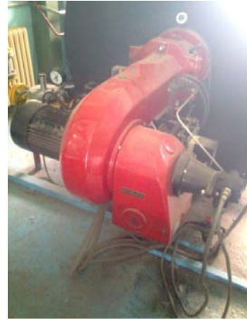
Слика 5. Горионик предметног котла
